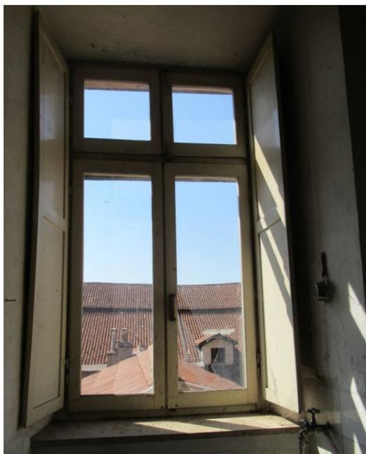
Figura 4 – Esempio di serramento dotato di telaio in legno e vetro singolo
