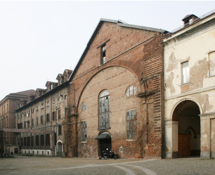
Attuale facciata - fronte Est
