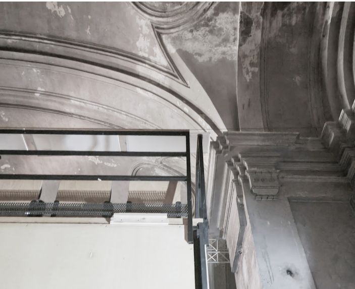
Degrado intonaci e stucchi
